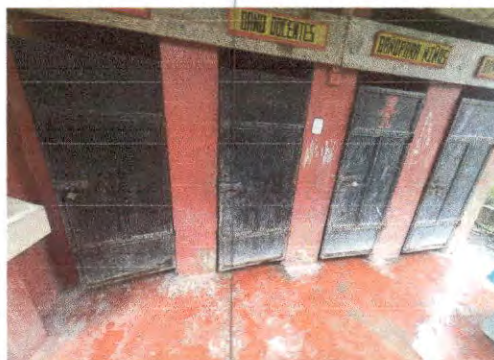
Foto 10: Mantenimiento a estructura (lijado, cambio de tubo, cepillado, sujeciones, aplicación de pintura) a las puertas de los servicios sanitarios.
