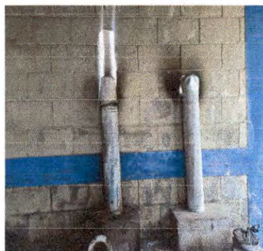
Foto 15: Sustitución de chimenea de metal por ladrillo
