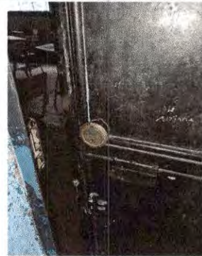
Foto 2: Sustitución de chapa
