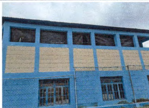
Foto13: Fabricación e instalación de ventana-balcon de metal (Chapa 18, con diseño para proteger del exterior) comedor escolar .
