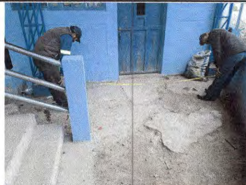
Foto 4: Reparación de piso de torta de concreto
