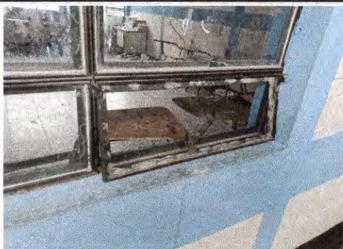
Foto 3: Sustitución de vidrios
