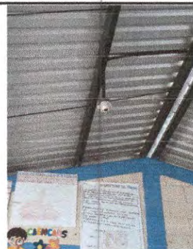
Foto 12: Sustrucción de lámparas tipo Led
