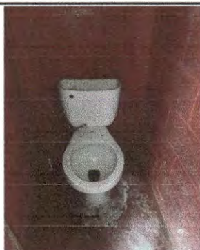
Foto 11: Sustrucción de inodoro y sustrucción de azulejo
