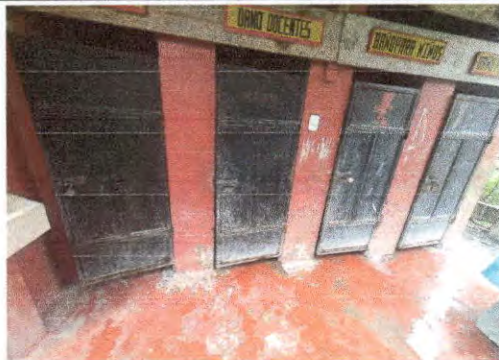
Foto 7: Sustrucción de piso líquido (por piso antideslizante en los baños)
