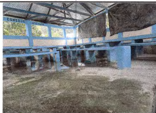
Foto 6: Sustitución de piso de torta de cocreto (Por piso de cemento líquido)
