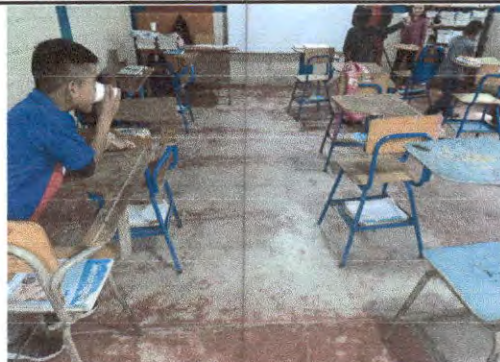
Foto 8: Sustrucción de piso de cemento líquido (Dirección y 2 módulos)
